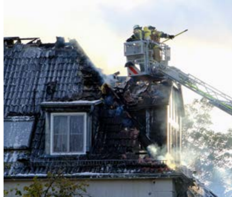
Brand eines Müllplatzes greift auf Wohnhaus über Bild: FD Feuerwehr Doku
