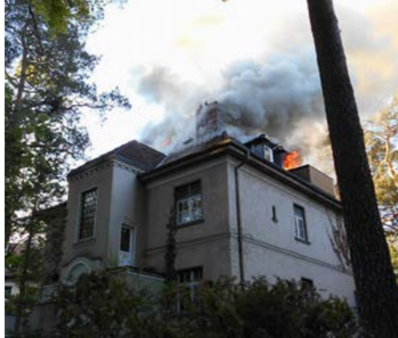
Dachstuhlbrand in Frohnau Bild: Berliner Feuerwehr
