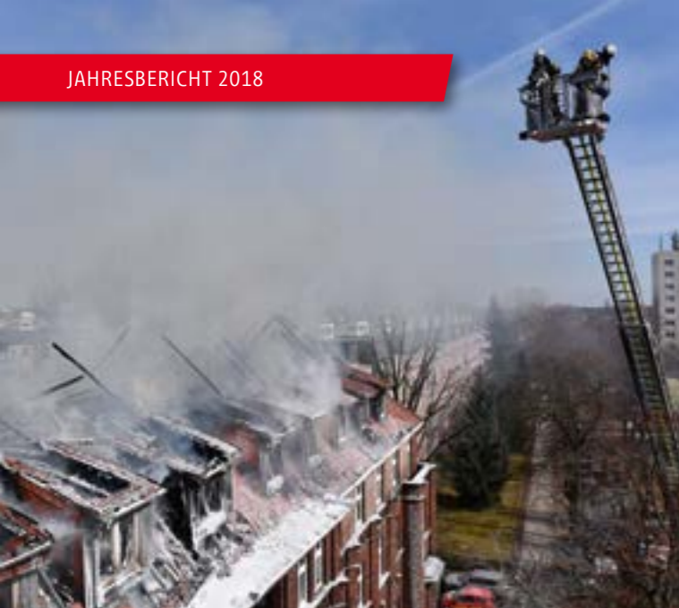
Dachstuhlbrand in Friedrichshagen Bild: Berliner Feuerwehr
