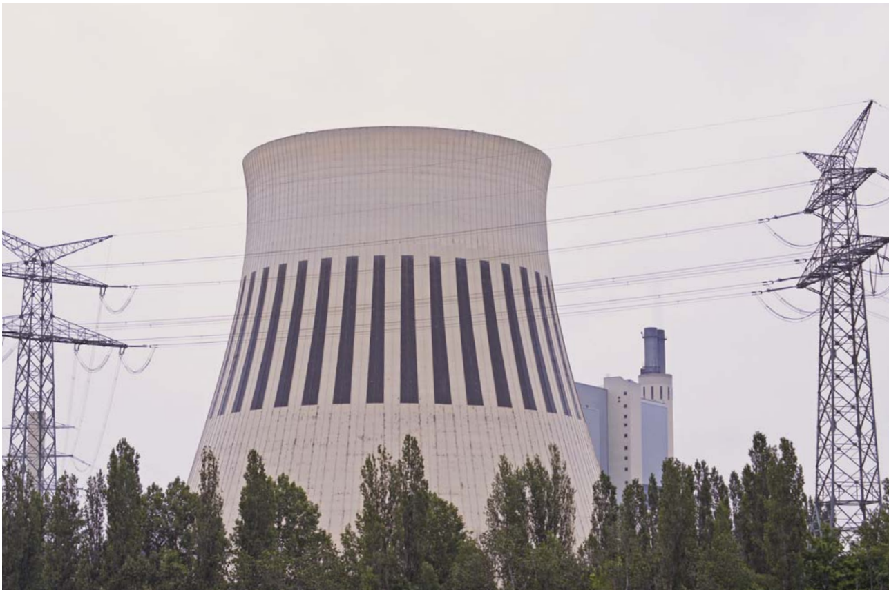
Kraftwerk Reuter West, Berlin
