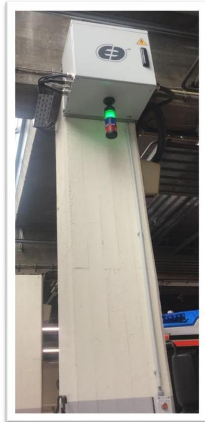
Abbildung 10: Schaltschrank mit Ladepunktsteuerung und Betriebszustandsanzeige
