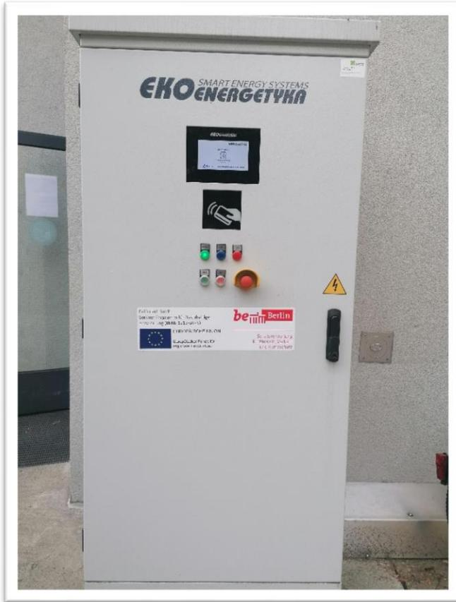
Abbildung 9: Stationäres DC-Schnellladesystem, Schaltschrank mit Leistungselektronik
