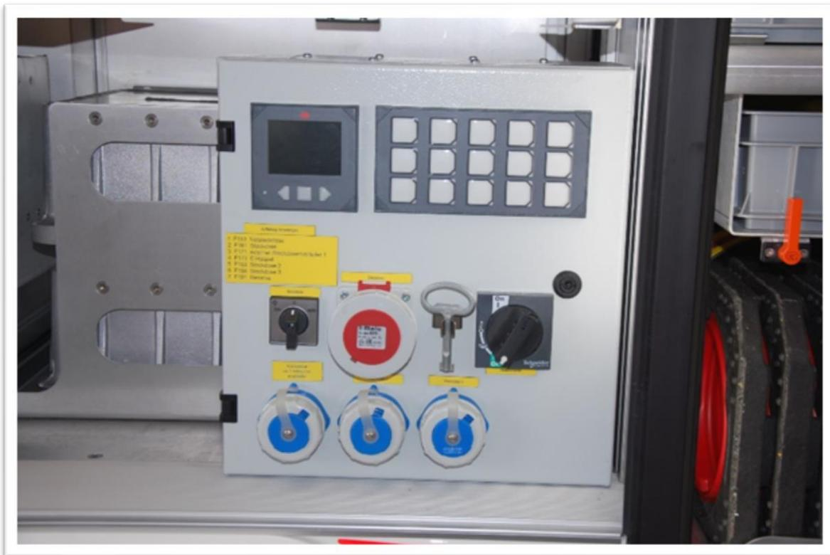
Abbildung 8: Netznachbildung mit Anschlusssteckdosen
